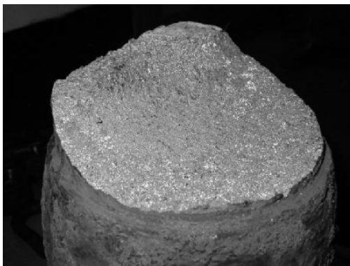
图1 钢拉杆断裂形貌（宏观照片 0.5×）
