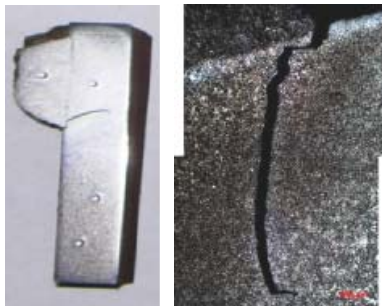
图 13 刚性梁与水冷壁管角焊缝裂纹处金相组织
